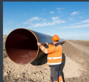
Monitorización de Corrosión en Tuberías
